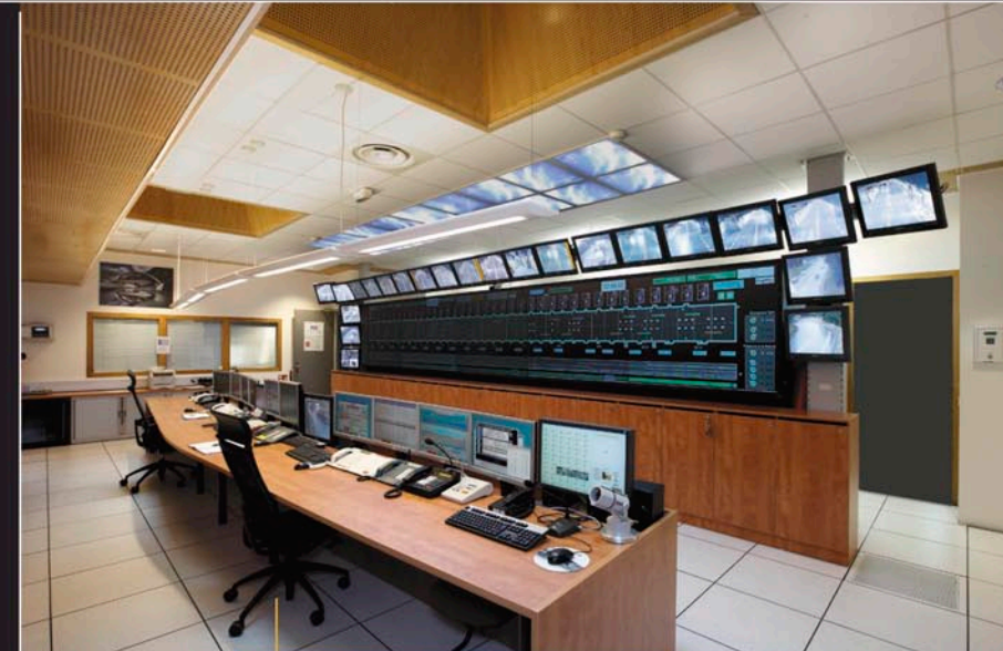
ATMB PC Tunnel du Mont blanc
